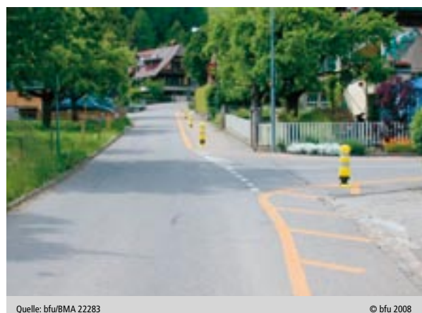
Abbildung 8 Absicherung eines Fussgängerlängsstreifens mit Pfosten
