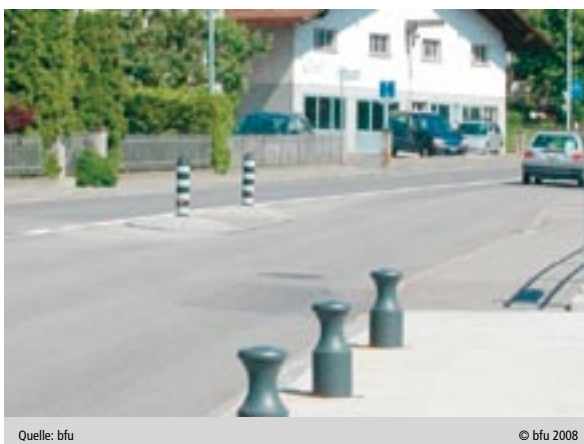
Abbildung 4 Querungshilfe für Fussgänger, ohne Fussgängerstreifen
