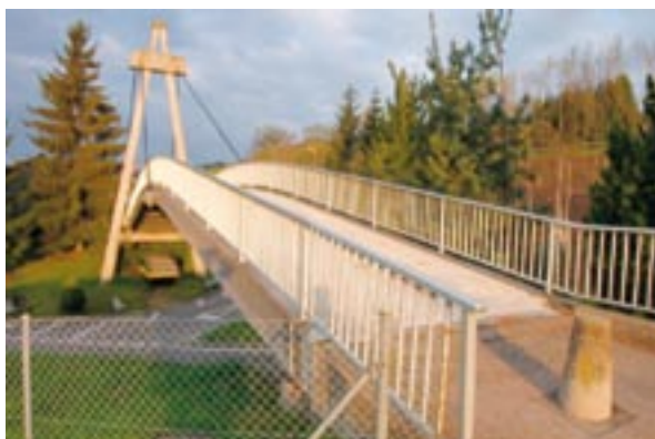
Abbildung 5 Überführung für den Fuss- und leichten Zweiradverkehr
